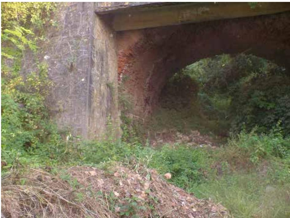
Fig. 5 - Un'altra vista del ponte a cui è accostato un manufatto recente in cemento armato
