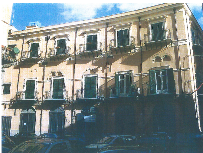
Fig. 5 – Via Alessandro Paternostro. Resti di finestre bifore di Palazzo Vanni (foto dell’Autore).
